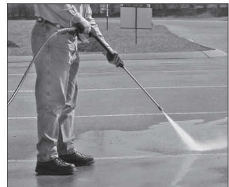
Figure 20 - Angle optimum par rapport à la surface à nettoyer
