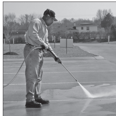
Figure 21 - Angle optimum par rapport à la surface à nettoyer
