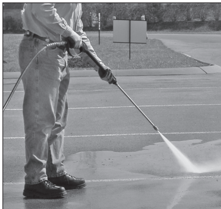
Figure 14 - Angle optimum par rapport à la surface à nettoyer
