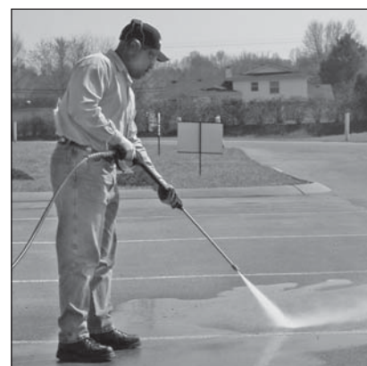
Figure 15 - Angle optimal de nettoyage de la surface
