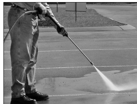
Figura 15 - Mejor ángulo de limpieza de superficies
