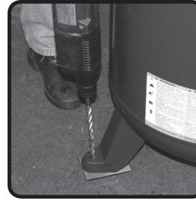
Utilisez les trous de montage et les trous des coussinets de vibration comme guide et **percez** des trous dans le béton avec le foret de maçonnerie de 9,5 mm (3/8 po). Les trous percés doivent être à au moins **12,70 cm (5 po)** dans le béton.
