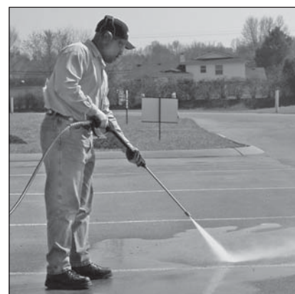
Figure 15 - Angle optimal de nettoyage de la surface
