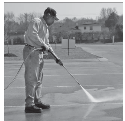
Figura 15 - Angle optimum par rapport à la surface à nettoyer
