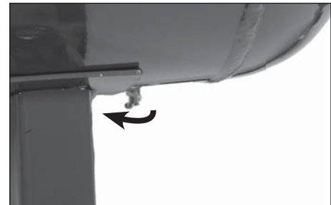
Figura 10 - Drenaje manual del tanque
