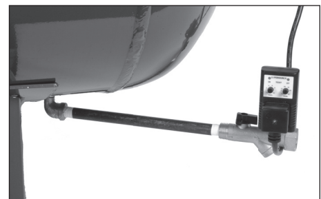
Figura 11 - Drenaje automático del tanque
