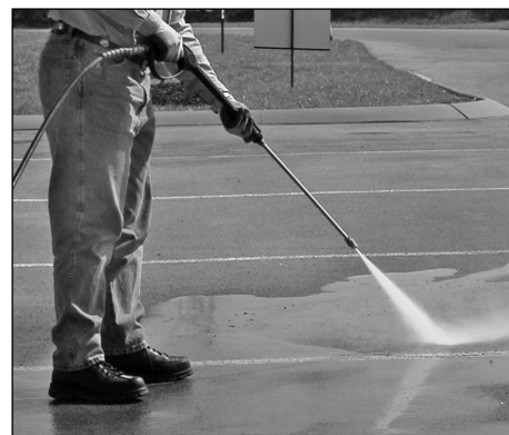
Figura 14 - Ángulo mejor para limpiar una superficie
