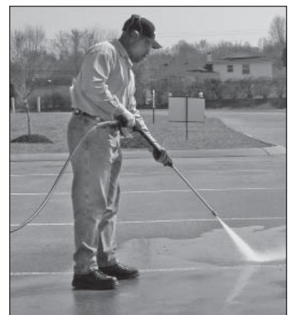
Figura 16 - Angle optimum par rapport à la surface à nettoyer
