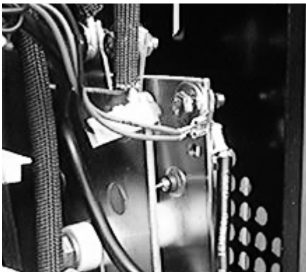
Fig. 4 – Reconnected Fig. 4 – Branché à nouveau Fig. 4 – Reconectado
